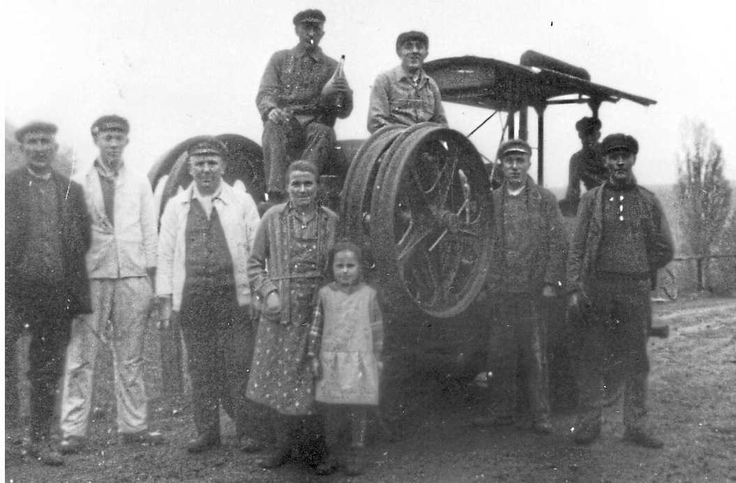
Bauarbeiten in Norheim 1933 durch Baugeschäft Gräff, Traisen.
