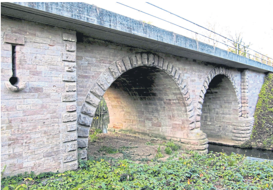
Die Altenbamberger Eisenbahnbrücke über die Alsenz mit der neuen Fahrbahnplatte.
