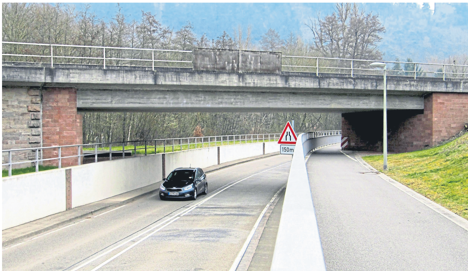
Die fertige Unterführung der B 48 in Altenbamburg.
