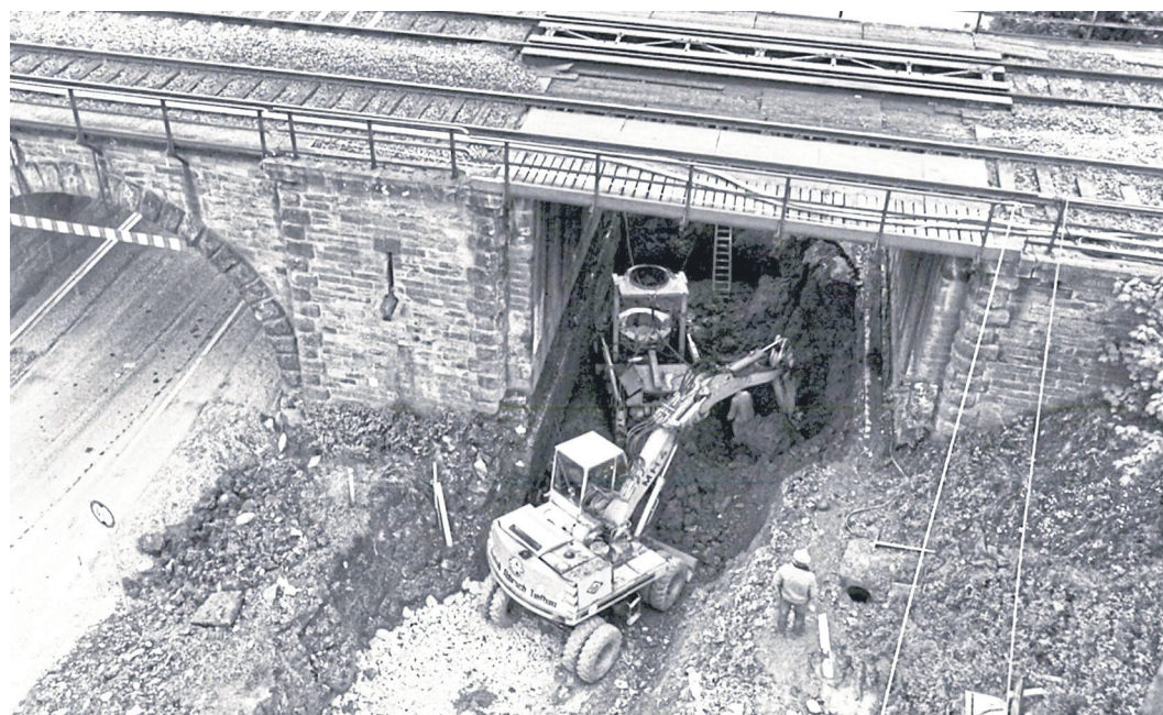
Baubeginn bei der Aufweitung der alten Eisenbahnunterführung. Auf dem Foto ist links die umgeleitete B 48, über dem Bagger die eingesetzte Behelfsbrücke zu erkennen.
